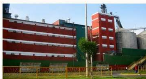
PLANTA INDUSTRIAL HUACHIPA
